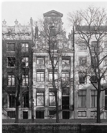
Aanvankelijk heeft de gevel van 't Witte Huys vier frontons. Bij een verbouwing in de 18 e eeuw wordt de entree verplaatst naar de rechterkant van het huis. Deze foto is gemaakt aan het begin van de 20 e eeuw.
