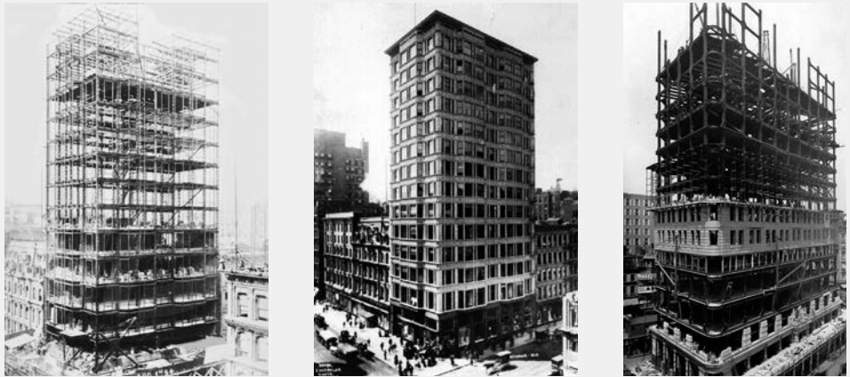
Figuur 1.5 Het Reliance building in aanbouw en na oplevering (Chicago), en (rechts) het Flatiron building in aanbouw (New York).
