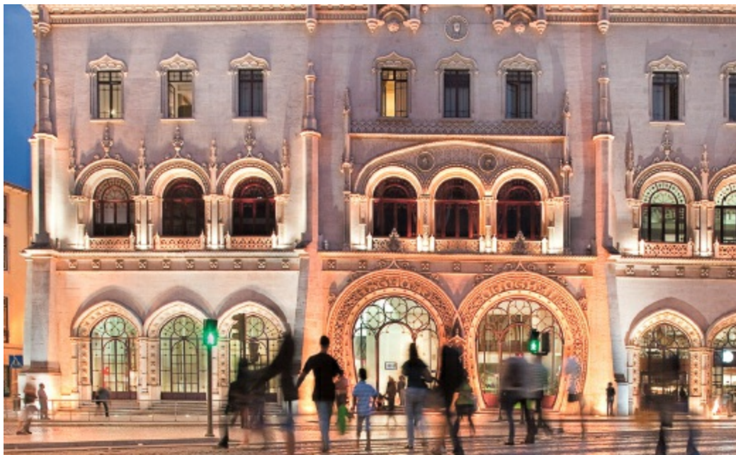
Niet alleen een station, maar ook een schitterend Jugendstilgebouw: het Estação do Rossio.
